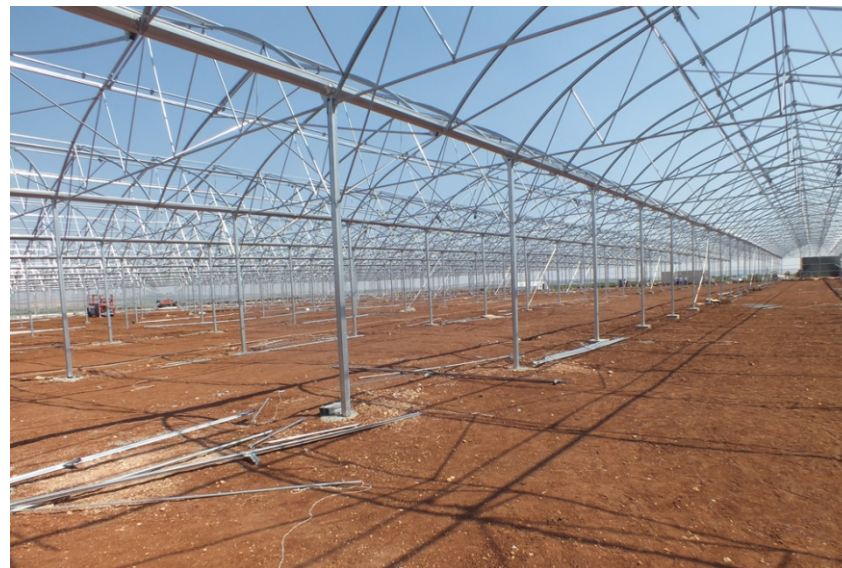
Structure métallique galvanisée
