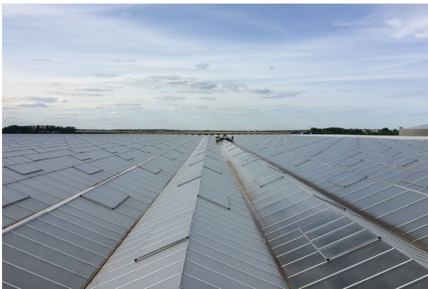
Matériaux de couverture UV-stabilisés
